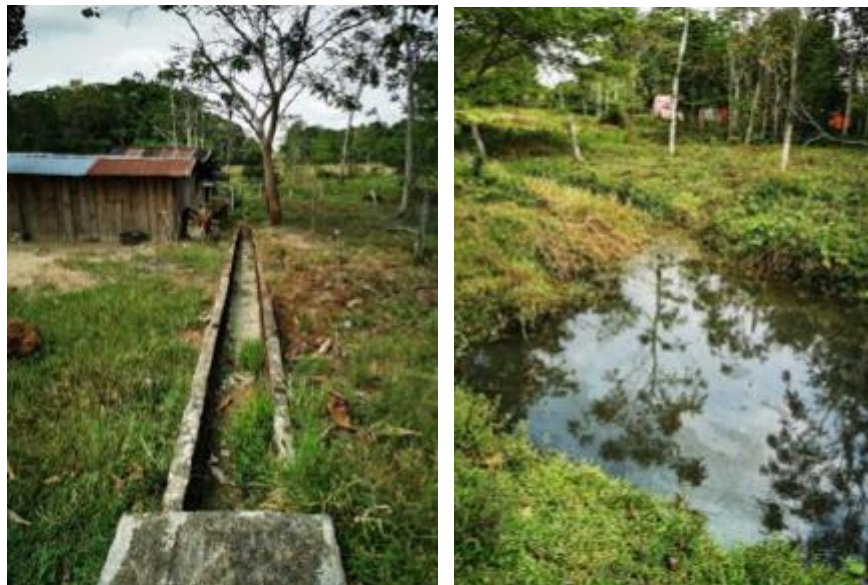
Fotografía 4 Canales perimetrales sobre las vías para el transporte de aguas residuales y aguas lluvias y disposición final en fuente superficial
