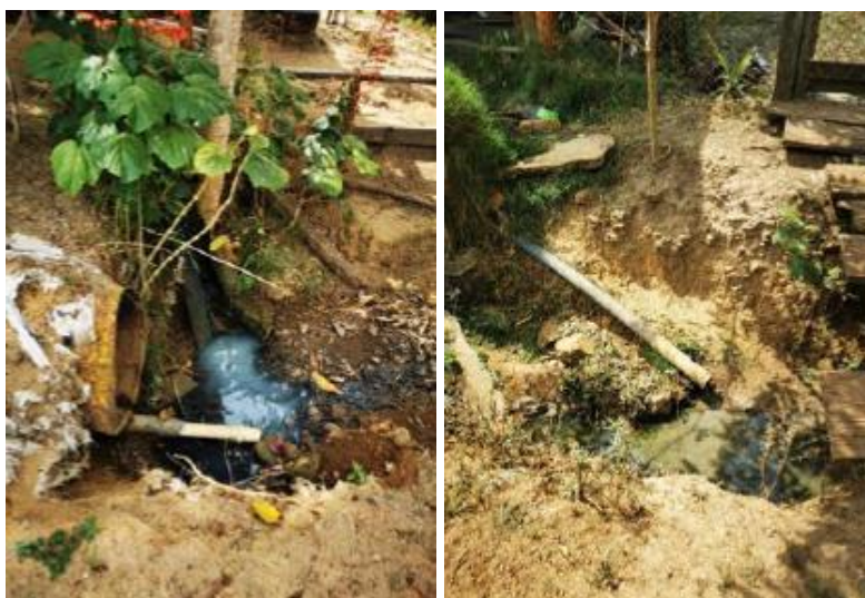
Fotografía 1. Vertimientos aguas residuales de las viviendas hacia las vías existentes
